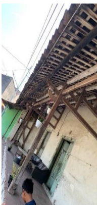
Gambar 17 Teritis Konstruksi Dou Gong Bangunan No.2 Fungsi Hunian
