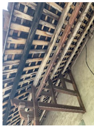
Gambar 17 Teritis Konstruksi Dou Gong Bangunan No.2 Fungsi Hunian
