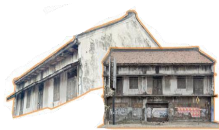
Gambar 38 Tampak Depan Bangunan No.8 Fungsi Hunian Tipe Ruko
