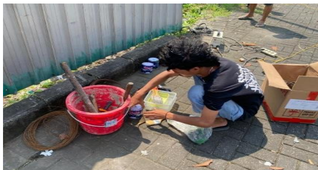
Gambar 5. Mengecat Pembatas Jalan
