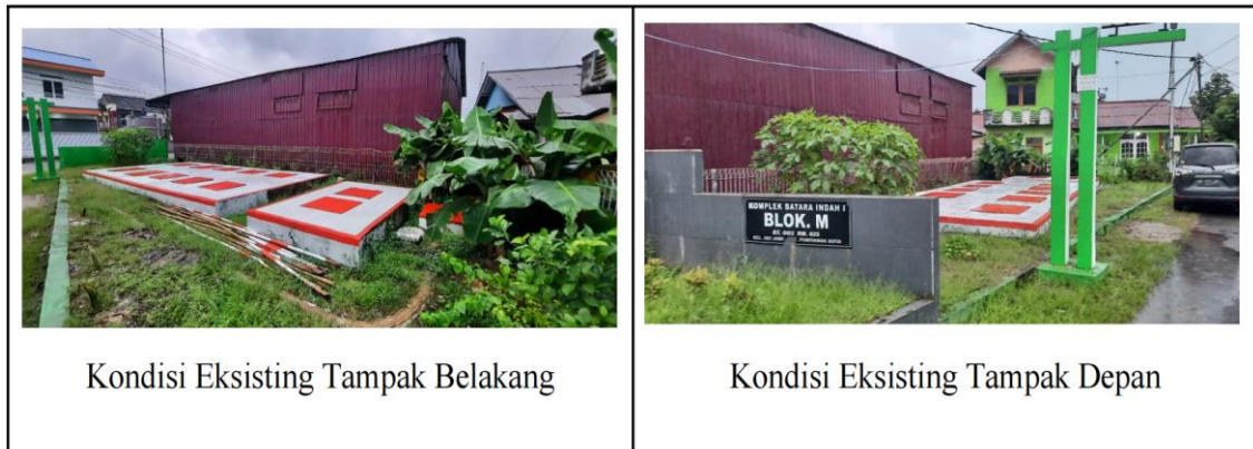
Gambar 2 Kondisi Eksisting Tapak
