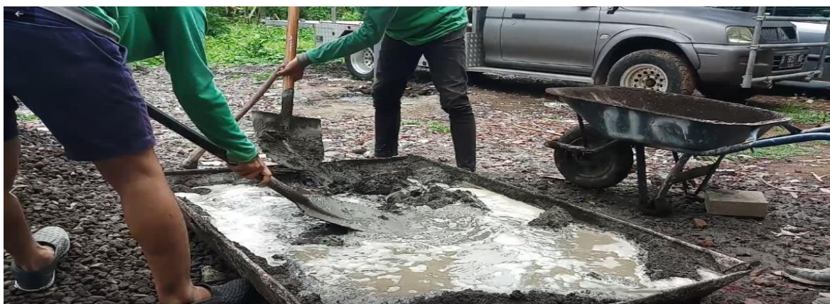
Gambar 6. Proses Pengadukan Material Dengan Ditambahkan Air
