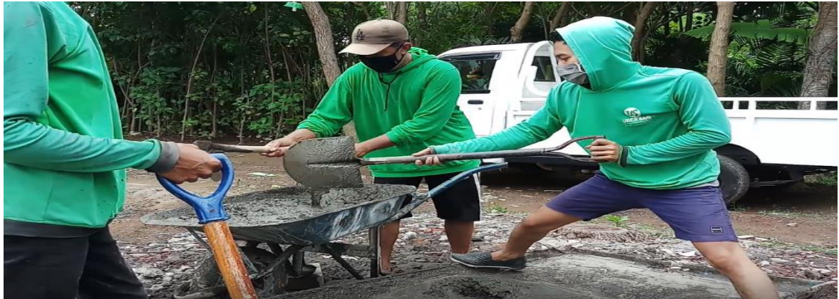
Gambar 7. Proses Memindahkan Campuran Beton Ke Dalam Artco
