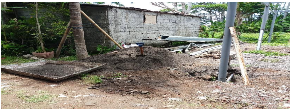
Gambar 2. Material dan Alat Campuran Beton
