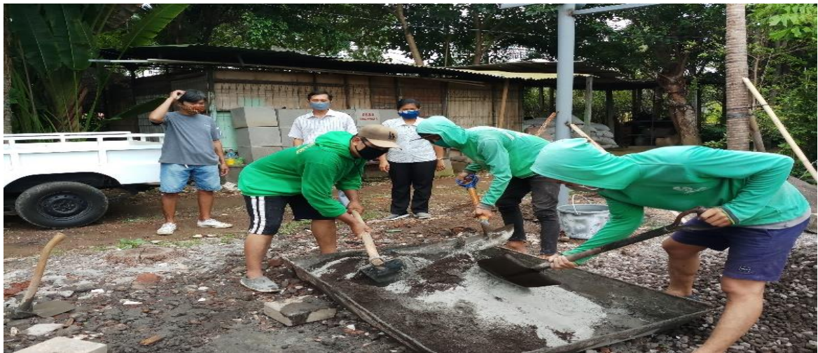
Gambar 5. Proses Pengadukan Material
