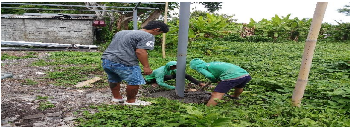
Gambar 9. Proses Meratakan Campuran Beton Pada Pondasi
