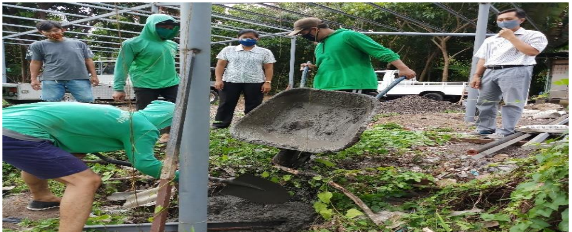
Gambar 8. Proses Menuangkan Campuran Beton Ke Dalam Pondasi
