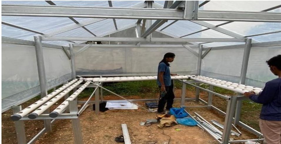
Gambar 6. Pembuatan pipa hidroponik
