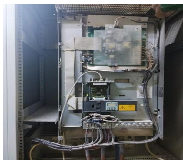
Gambar 3. 1 Sistem Kontrol VSD Dan Variabel Speed Drive
