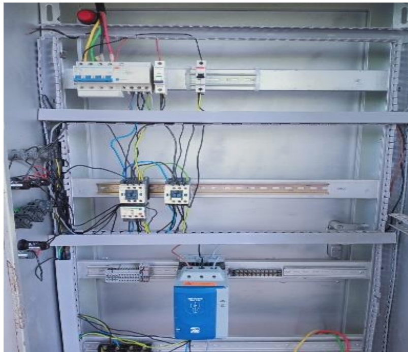
Gambar Rangkaian Kontrol pada panel
